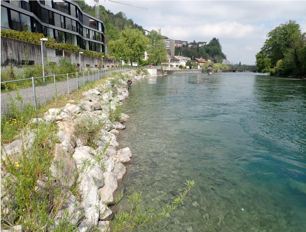
Abb. 15 Im Quartier Reussinsel wurde am linken Ufer ein Verbau mit glattem Mauerwerk durch Blockwurf ersetzt. Foto K. Guthruf.
