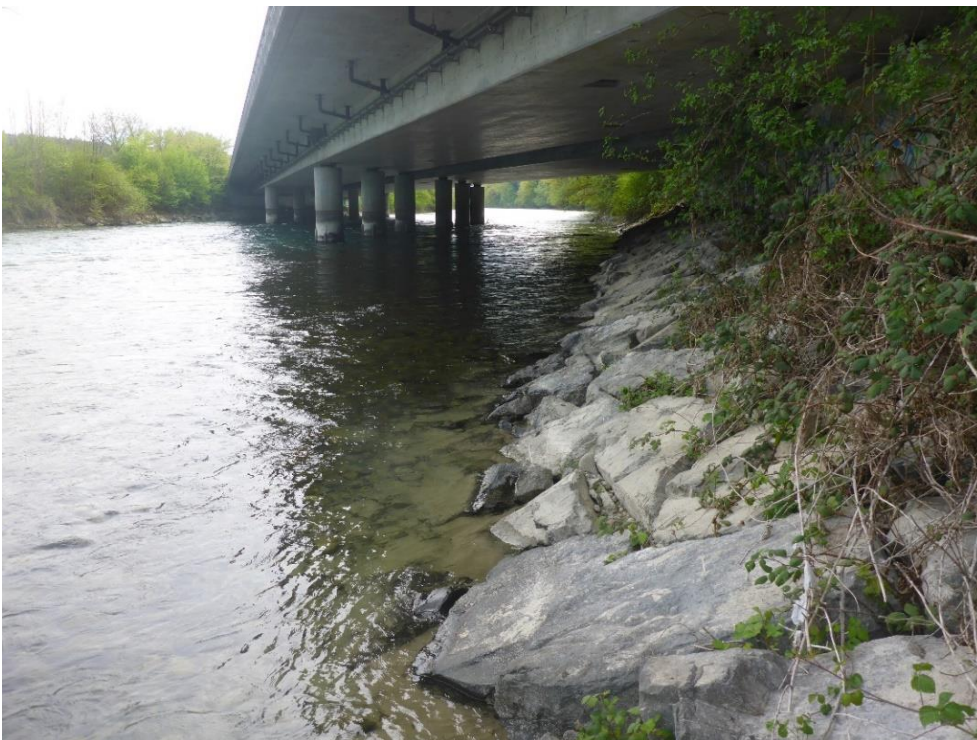
Abb. 8 Blocksatz am linken Ufer der Reuss unterhalb der Autobahnbrücke bei Buchrain, Blick flussaufwärts. Das gegenüberliegende Ufer ist ebenfalls mit Blocksatz verbaut. Foto K. Guthruf.
