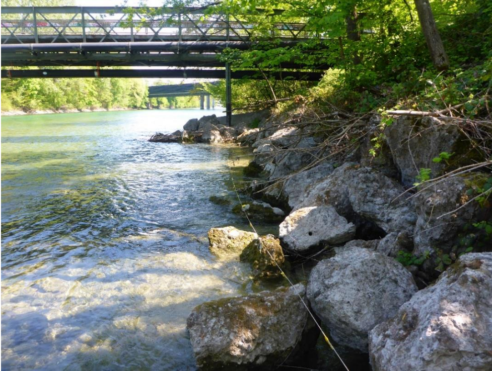
Abb. 7 Blockwurf am rechten Ufer der Reuss oberhalb der Sädelbrücke, Blick flussabwärts. Die Blöcke liegen unregelmässig. Foto K. Guthruf.
