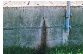
Risse und Spalten in der Grubenwand führen zu undichten Behältern. In beiden Fällen ist eine Sanierung notwendig.
